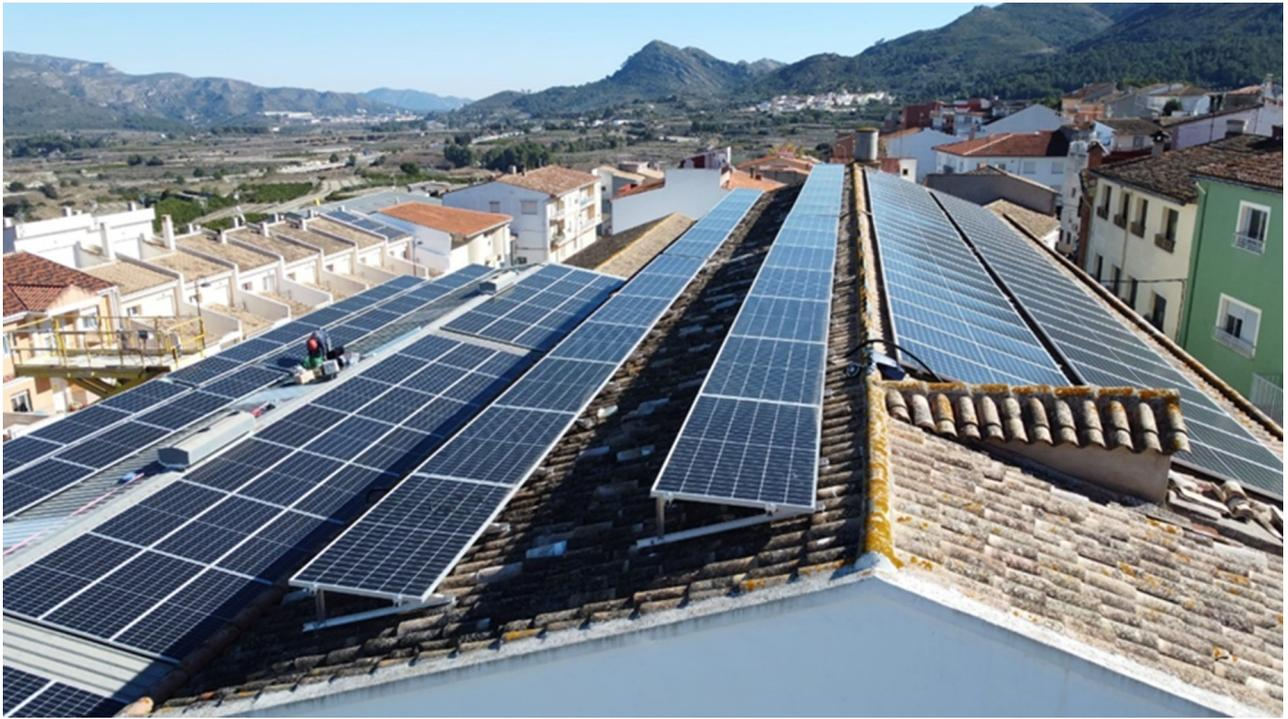
**Figura 17:** Implantación final de la instalación de autoconsumo colectivo en la cubierta de Agrícola Montitxelvo (Montitxelvo - Valencia).
